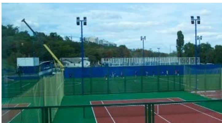
Bauboom am Trainingsgelände am Otrada-Strand
